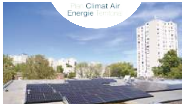
Photovoltaïque à Lorca
