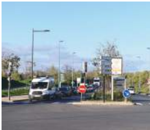
Aménagement au Pont de la Soie
