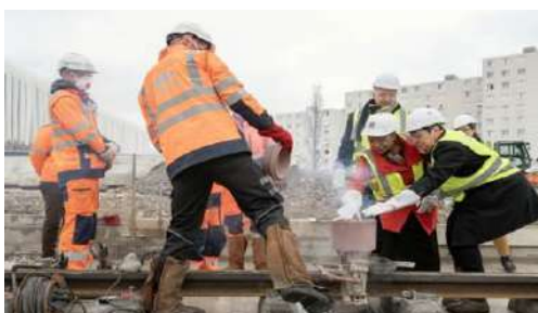
Pose du premier rail du tramway T9 (© L. Cerino)
