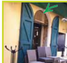
Dans l'arc de l'ouverture
