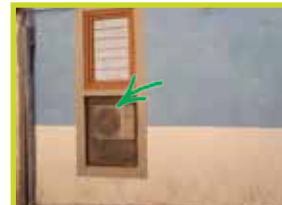
Dans une niche de la maçonnerie
