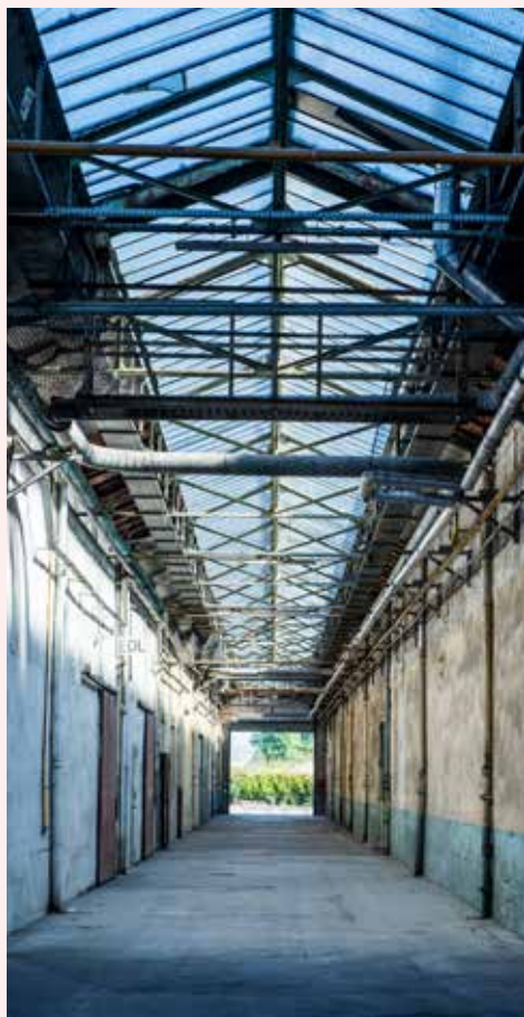
Sheds de l'usine TASE © Eric Soudan - Métropole de Lyon
