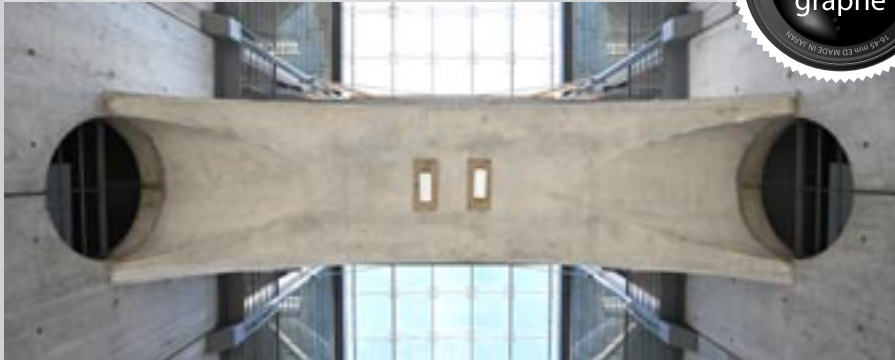
Dessous d'une passerelle de l'École nationale supérieure d'architecture de Lyon (Ensal)
